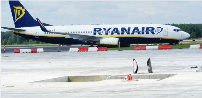
Fertiggestellte Betondecke am Flughafen Riga
