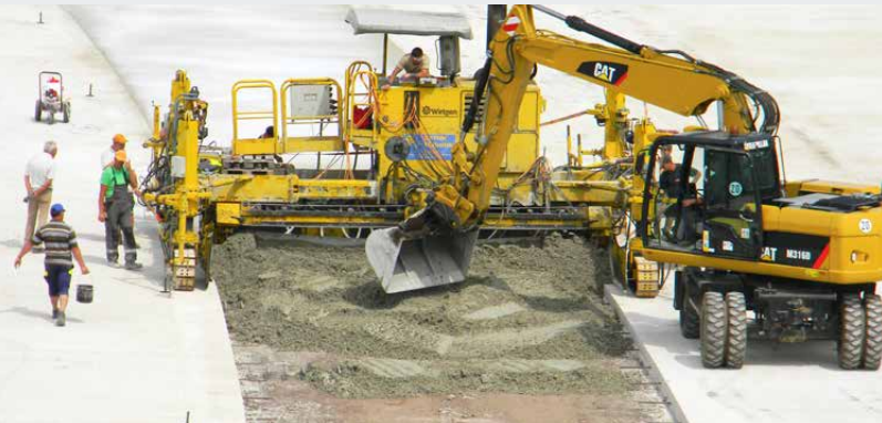
Betoneinbau mit SP 500 in der Hafenanlage Minden
